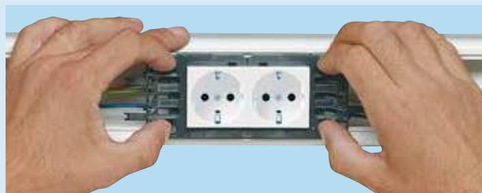
Монтаж розеток Mosaic в кабель-каналы DLP
