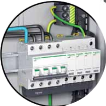
Ограничитель напряжения iPRD 4P + iC60N 4P
