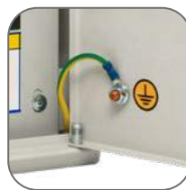
Обмедненные шпильки. Закрепленный поводок заземления
