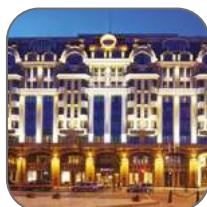
Защита высотных домов и гостиничных комплексов
