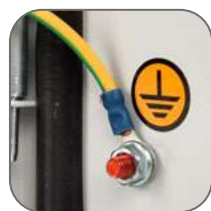
Обмедненные шпильки. Закрепленный поводок заземления
