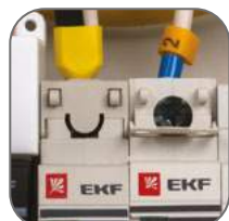
Имеет пломбировку вводного аппарата
