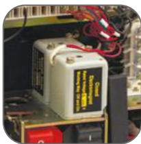
Катушки включения/отключения в базовой комплектации
