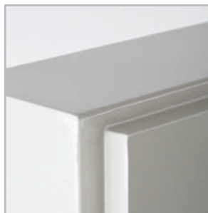
Полностью проваренные швы.
