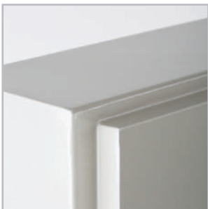
Полностью проваренные швы.
