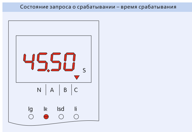
Состояние запроса о срабатывании – время срабатывания
