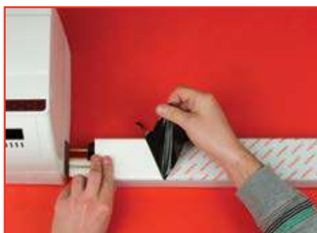
Снимите с крышки защитную пленку
