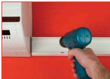
Закрепите основание короба на стене
