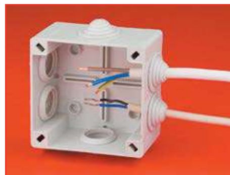
3 этап. Ввод кабеля
