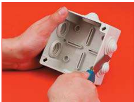
1 этап. Срезаем кабельный ввод
