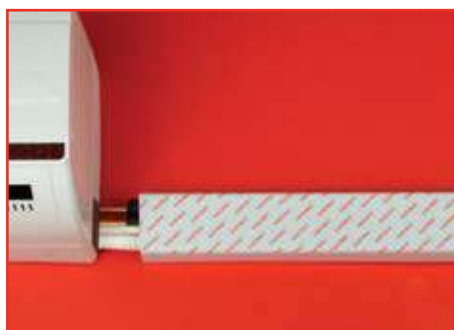
Закройте смонтированную трассу крышкой
