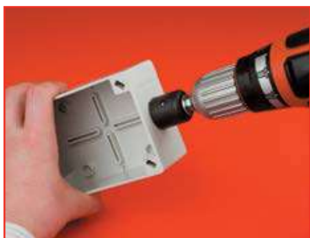
1 этап. Сверлим отверстия необходимого диаметра
