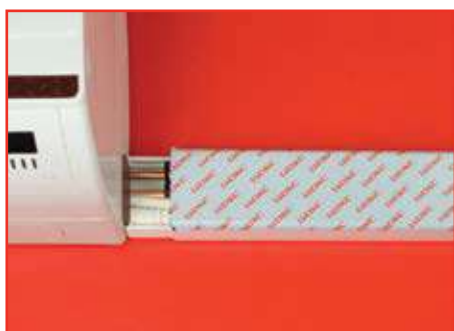
Закройте смонтированную трассу крышкой
