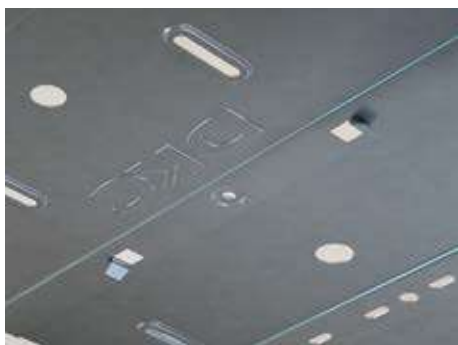
Предварительная безвинтовая фиксация
