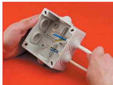
3 этап. Ввод кабеля
