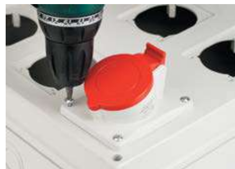
Монтаж розетки на 32 А
