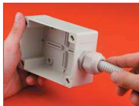
3 этап. Осуществляем ввод трубы и кабель
