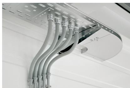
Дополнительные отверстия в дне листовых лотков необходимы для безопасного присоединения кабеля при помощи кабельных вводов.
