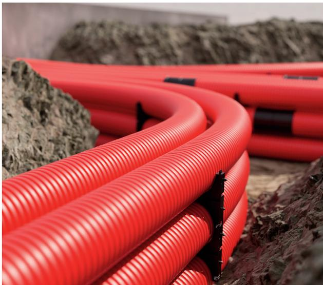
Двустенные трубы предназначены для прокладки силовых кабелей, а также информационных и сигнальных линий связи (в том числе оптоволоконных) в грунте, внутри железобетонных конструкций или в открытых электроустановках. Двустенные трубы ДКС – современное решение, обеспечивающее надежную защиту кабелей от механических повреждений и агрессивного воздействия окружающей среды.
