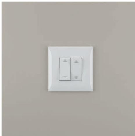
5. В конце помещаем каркас обратно в подрозеточную коробку и устанавливаем рамку. Подсветка будет гореть при разомкнутой цепи (выключенном выключателе). Выше представлены фото ЭУИ при выключенном и включенном свете.
