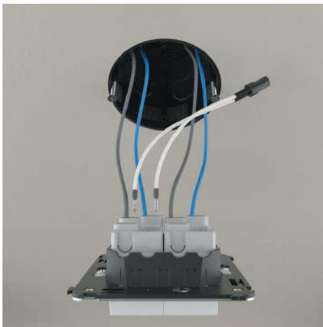
2. Откручиваем обе клеммы выключателя, после чего устанавливаем обжатые проводники подсветки в выключатель, как показано на фотографии.
