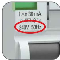
**Номинальное напряжение  $U_n$**  – действующее значение напряжения, при котором УЗО полностью работоспособно.
