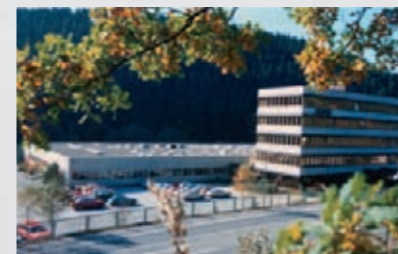
1985 г. – здание центрального управления на Вольмештрассе в Шальксмюле
