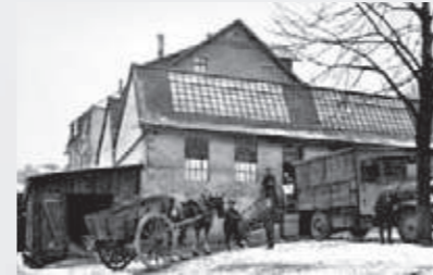
„1912 г. – постройка первого здания фабрики JUNG в городке Шальксмюле
