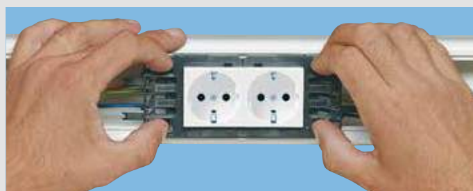
Монтаж розеток Mosaic в кабель-каналы DLP
