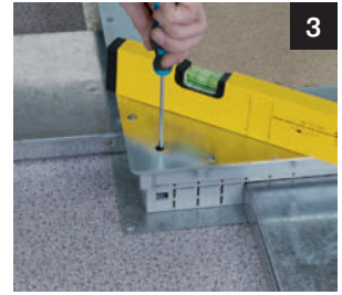
3 При помощи регулировочных винтов выставить уровень
