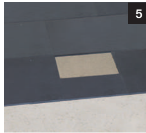
5 Монтаж покрытия поверхности пола
