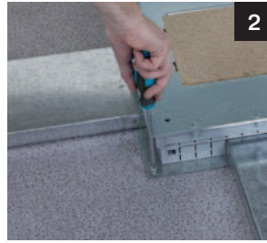
2 Закрепить коробку на полу
