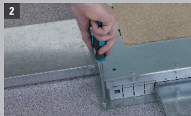
2 Вставить кабель-каналы и привинтить к полу
