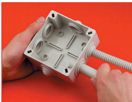
2 этап. Ввод гофрированной и жесткой трубы
