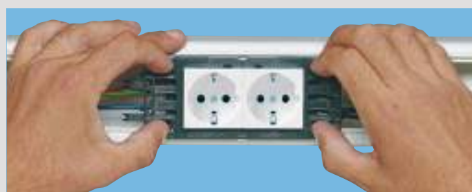
Монтаж розеток Mosaic в кабель-каналы DLP
